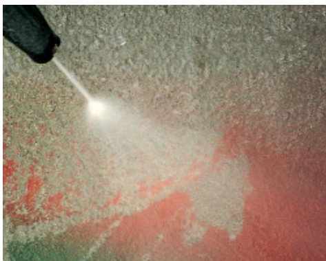
WallGard Graffiti Barrier-rel kezelt beton tisztítása
