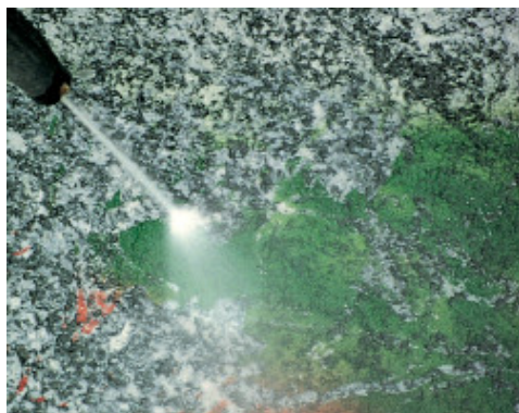
Nagynyomású vízsugaras tisztítás WallGard Graffiti Barrier-rel kezelt grániton
